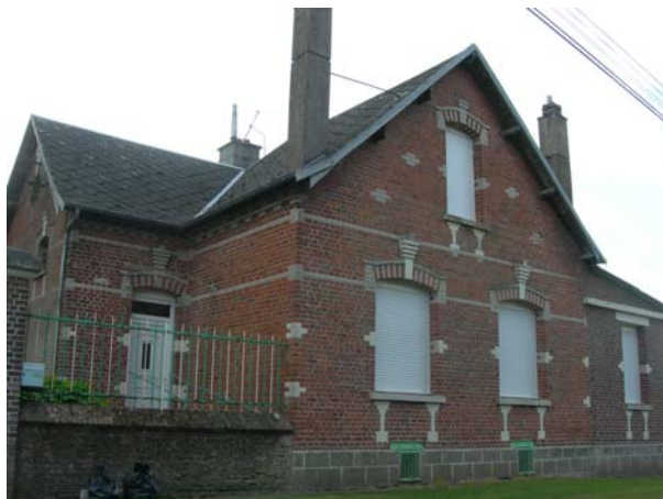
Les façades, et notamment les appareillages de briques, sont travaillés, dessinant des détails géométriques variés
