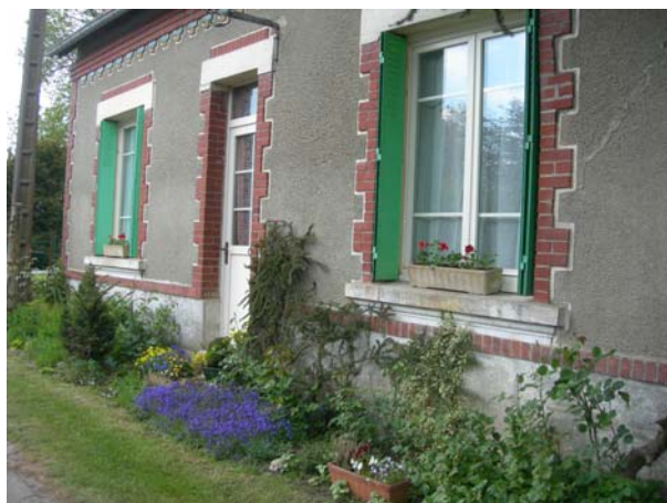
Les maisons à trois travées sont également typiques de la 1 ère Reconstruction et nombreuses à Pozières
